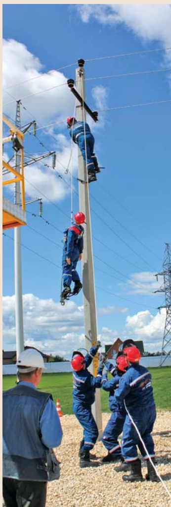
Сергей Бортников, начальник Службы распределительных кабельных сетей, старший судья этапа «Замена штыревого изолятора на промежуточной деревянной опоре со стеленом загнивания древесины выше нормы на ВЛЗ-10 кВ»:
