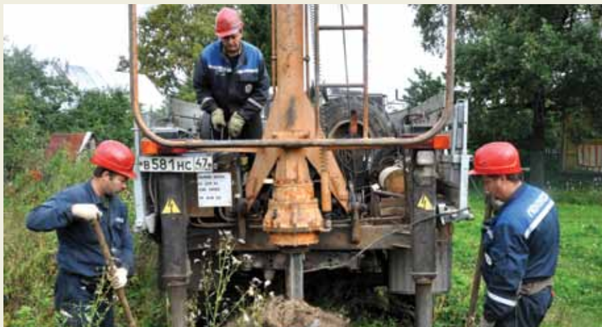
▲ Николай Ильинский, мастер Пудостьского участка Гатчинского РЭС и водители БКМ Александр Эскелинен и Юрий Петренко устанавливают опору на линии электропередачи
