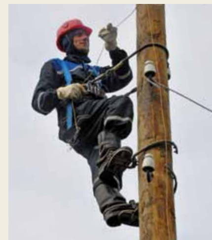
▲ На опоре — Иван Часовских, электромонтер Пудостьского участка Гатчинского РЭС
