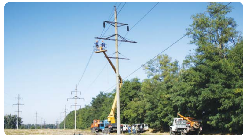
Ремонт электросетевого оборудования направлен на повышение качества и надежности электроснабжения жителей Краснодарского края и Республики Адыгея в осенне-зимний период
