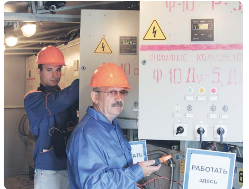
Специалисты группы по контролю качества электрической энергии службы метрологии и контроля качества электроэнергии Александр Ратиев и Алексей Пустовой производят замену приборов системы диспетчерского управления подстанции «Роговская»
