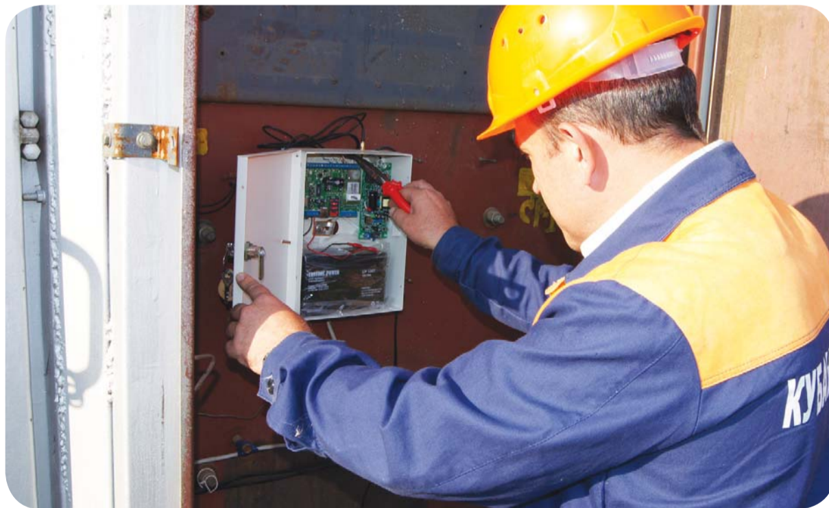
Монтаж GSM-сигнализации на объекте Тихорецких электрических сетей
